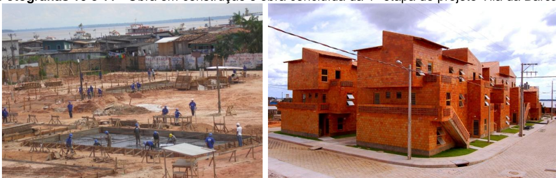
Fotografias 10 e 11 - Obra em construção e obra concluída da 1ª etapa do projeto Vila da Barca.
